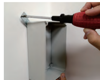
通过安装挂脚固定
