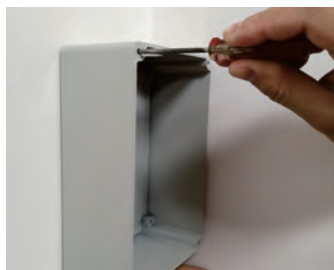
通过盒体的通孔用螺丝直接固定
